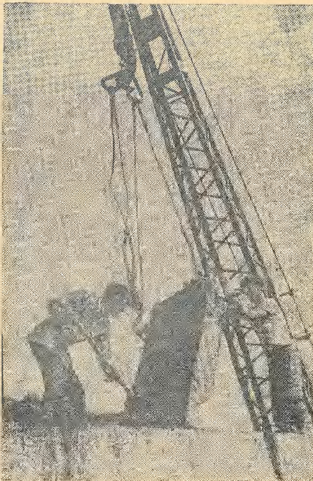
На бетонных работах.
