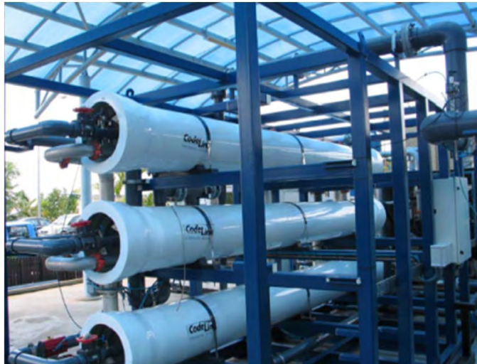
Создание опреснительных мембранных установок на солнечных батареях
